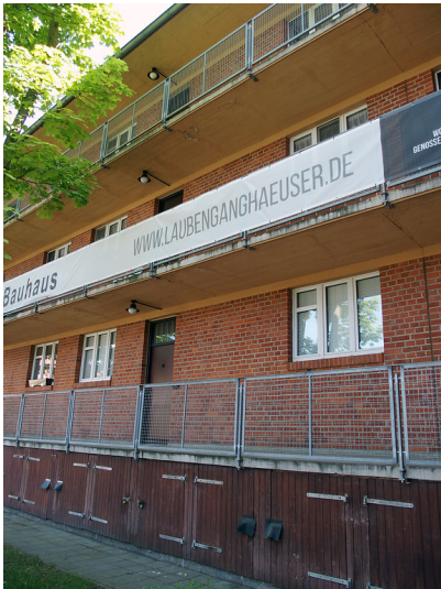
Laubenganghäuser Dessau (2018) Fotograf/Urheber: Karl Peter Wiemer
