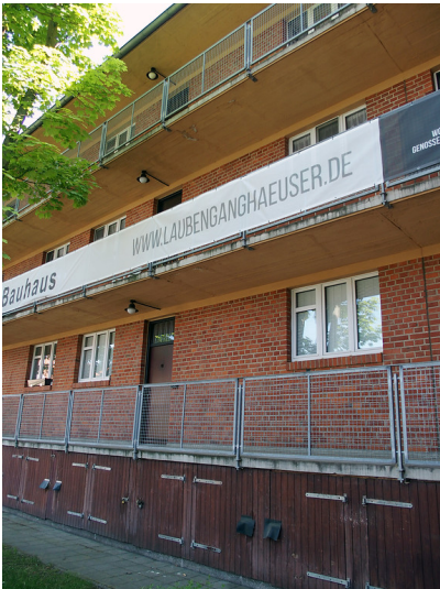
Laubenganghäuser Dessau (2018) Fotograf/Urheber: Karl Peter Wiemer
