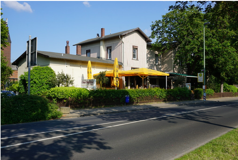
Bahnhof Meerbusch-Osterath, Empfangsgebäude (2018) Fotograf/Urheber: Claus Weber
