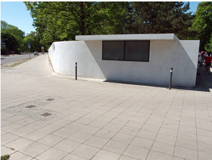
Trinkhalle auf dem Grundstück des Direktorenhauses Gropius (2018) Fotograf/Urheber: Karl Peter Wiemer
