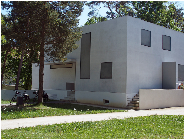
Neue Meisterhäuser in Dessau (2018) Fotograf/Urheber: Karl Peter Wiemer
