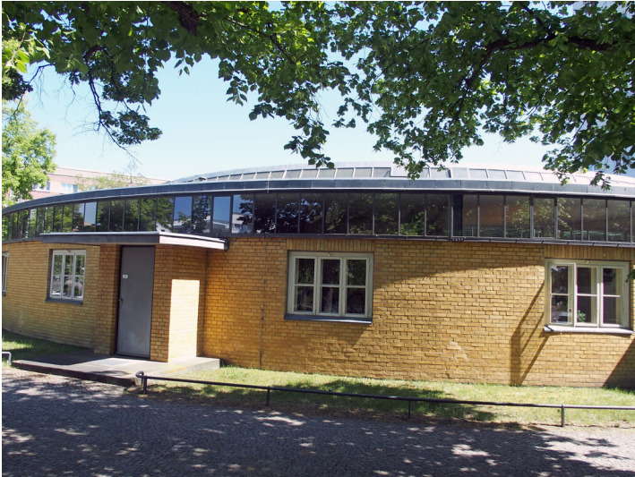
Arbeitsamt Dessau (2018) Fotograf/Urheber: Karl Peter Wiemer
