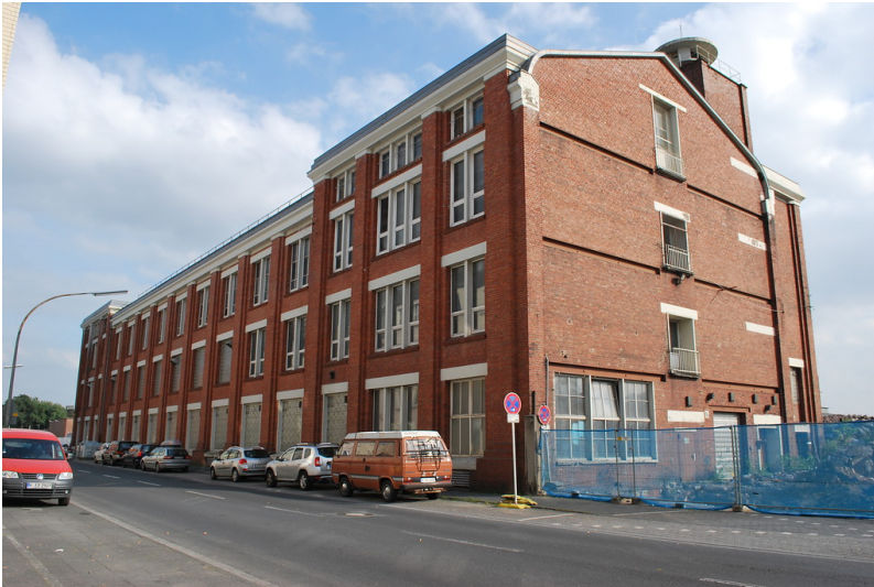
Gummifabrik Clouth von 1925/26, Halle 18 an der Xantener Straße in Köln-Nippes (2014). Fotograf/Urheber: Gelhar, Martina
