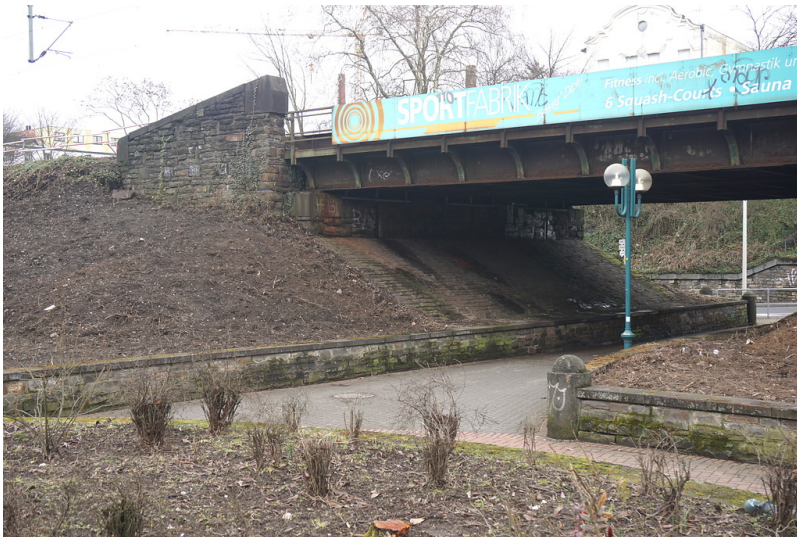
Eisenbahnbrücke Friedrich-Breuer-Straße in Bonn-Beuel (2018) Fotograf/Urheber: Claus Weber
