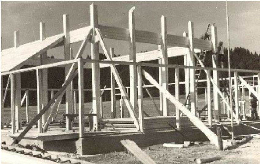
Hölzerne Wandkonstruktion der evangelischen Kirche Oberpleis (1949).
