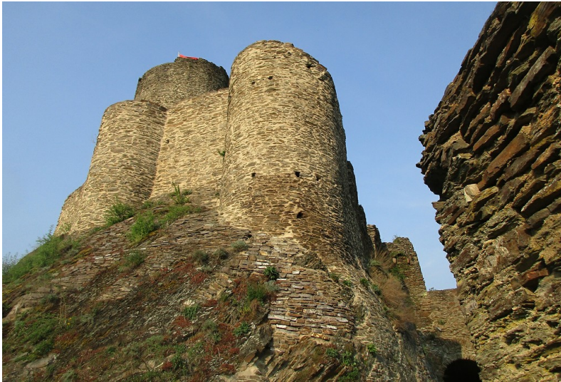
Bergfried und Mauern des oberen Burghofs der Ruine der Winneburg bei Cochem, Ansicht von Südwesten (2018). Fotograf/Urheber: Franz-Josef Knöchel
