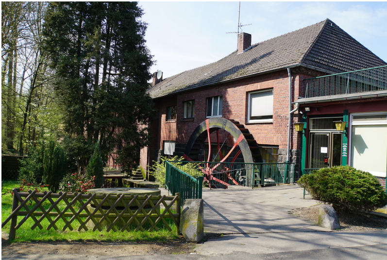
Holzmühle (2018) Fotograf/Urheber: Sibylle Maringer
