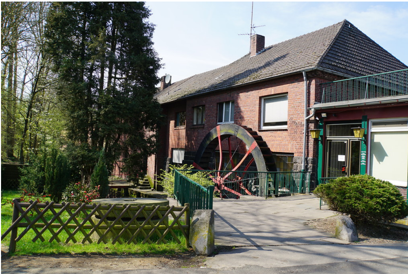
Holzmühle (2018) Fotograf/Urheber: Sibylle Maringer
