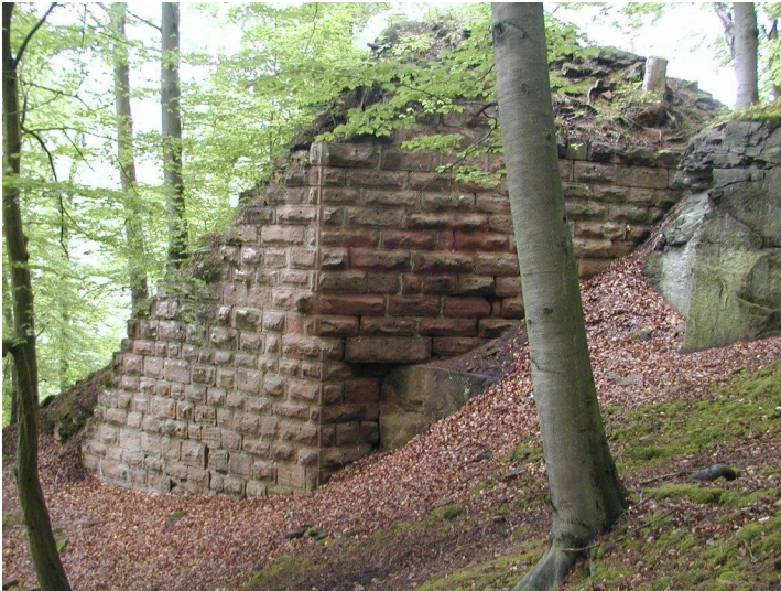
Rest der Schildmauer der Burgruine Lichtenstein bei Neidenfels. Fotograf/Urheber: Jürgen Keddigkeit
