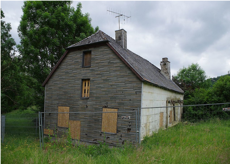
Die Alte Gerberei Hellenthal, auch "Haus Krämer" bzw. "Gerberei Matheis" genannt, Ansicht der Nordostseite (2017). Fotograf/Urheber: Werner von Basil
