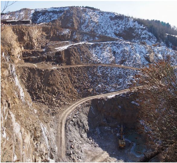
Steinbruch Fa. Quirrenbach, Lindlar: Blick von der Straße in den Bruch. (2018) Fotograf/Urheber: Jörn Kling
