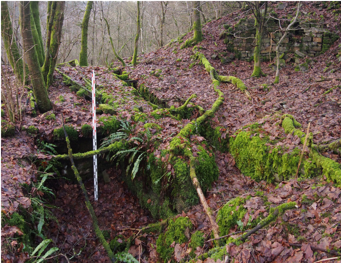
Bergstation einer Bremsbahn (BB 6), Felsenthal West 3 (2018) Fotograf/Urheber: Jörn Kling
