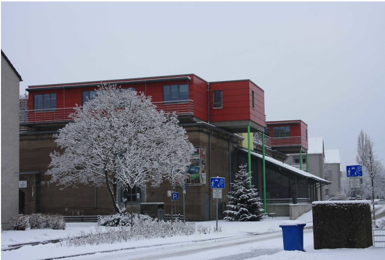
Hochbunker in Oberhausen, heute Bürgerzentrum und Bunkermuseum Oberhausen (2010) Fotograf/Urheber: Juergen59
