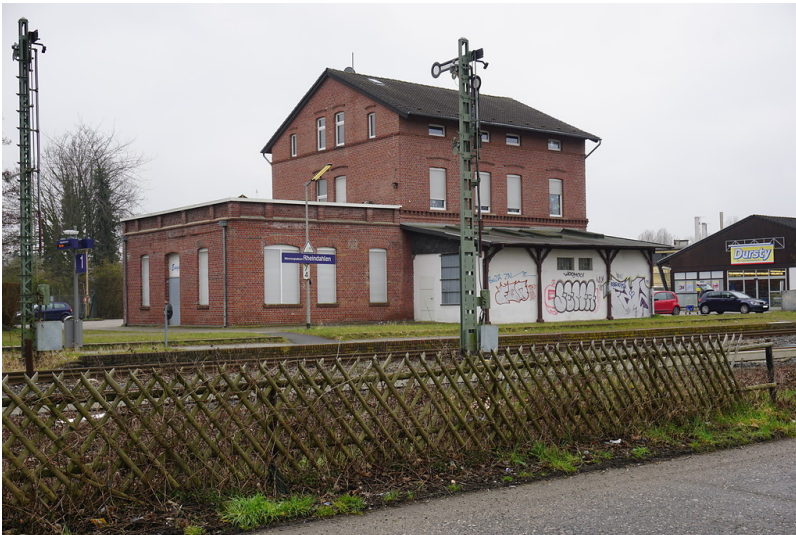
Bahnhof Mönchengladbach-Rheindahlen (2018). Empfangsgebäude, Gleisseite. Fotograf/Urheber: Claus Weber
