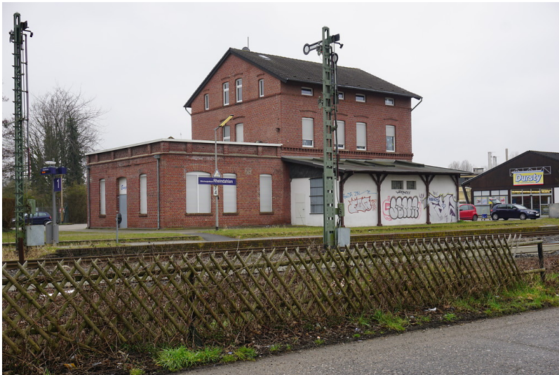
Bahnhof Mönchengladbach-Rheindahlen (2018). Empfangsgebäude, Gleisseite. Fotograf/Urheber: Claus Weber
