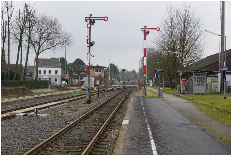
Bahnhof Mönchengladbach-Rheindahlen (2018). Bahnhofsgelände, Blick Richtung Rheydt, Ausfahrtsignale. Fotograf/Urheber: Claus Weber
