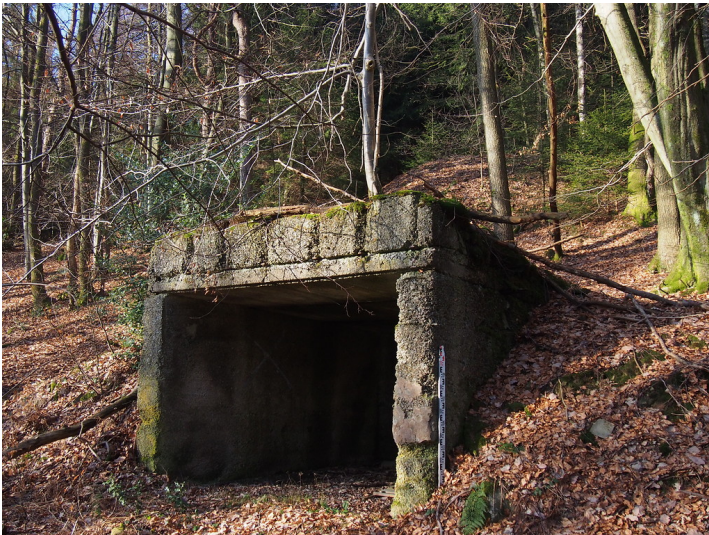
Pulverkammer PK 1 oder Untertand aus Stampfbeton am Bruch Obernhagen 3. (2018) Fotograf/Urheber: Jörn Kling
