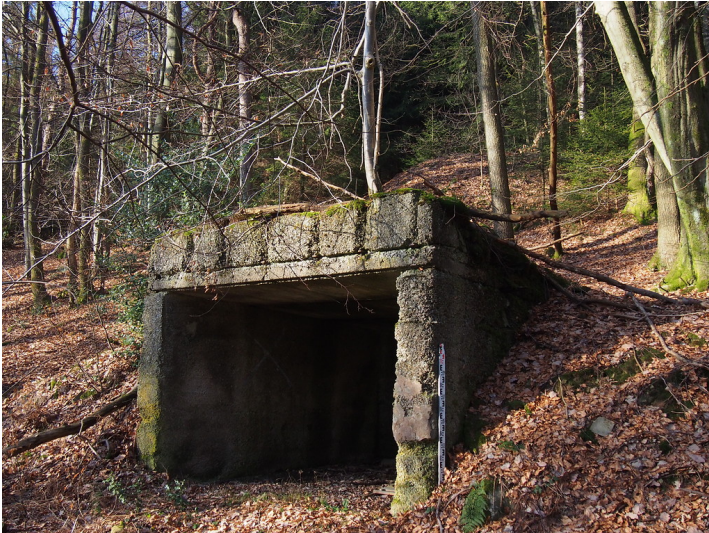
Pulverkammer PK 1 oder Untertand aus Stampfbeton am Bruch Obernhagen 3. (2018) Fotograf/Urheber: Jörn Kling
