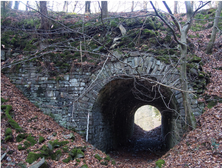
Tunnel für Feldbahn. Steinbruch Müllenbach 3. (2018) Fotograf/Urheber: Jörn Kling
