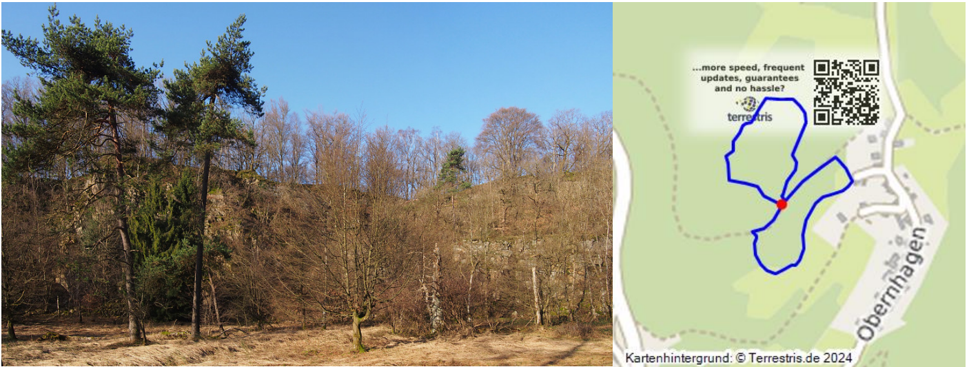
Noch recht offener Abbaukessel des Bruchs. Durch die Bäume kann man den Absatz einer 2. Sohle erkennen. Steinbruch Obernhagen. (2018) Fotograf/Urheber: Jörn Kling
