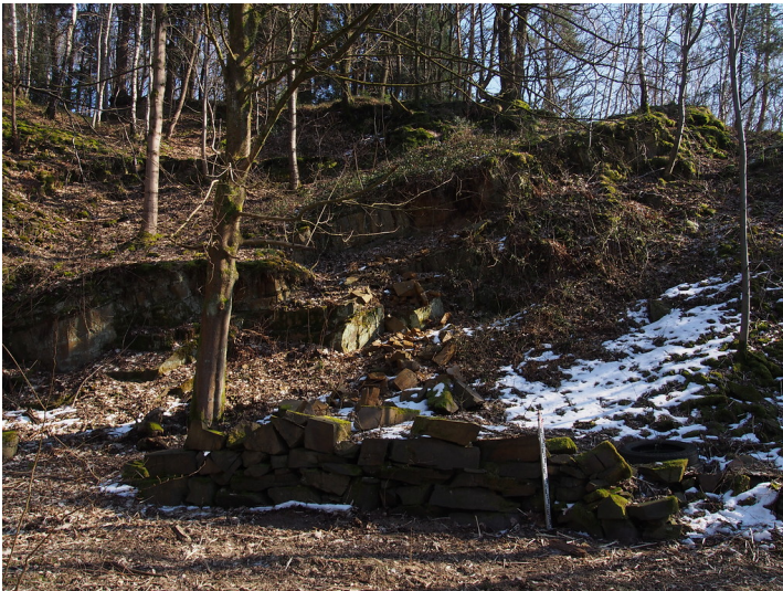
Östliche Bruchflanke Steinbruch Wolfsschlade bei Lindlar. (2018) Fotograf/Urheber: Joern Kling
