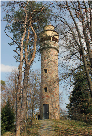
Sattelbergturm auf dem Sattelberg bei Seelen (2011) Fotograf/Urheber: Werner Lademann
