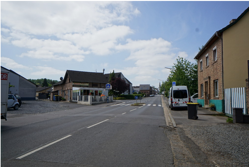
Stationsgebäude der Euskirchener Kreisbahn in Erftstadt-Erp (2018) Fotograf/Urheber: Sabrina Ranke
