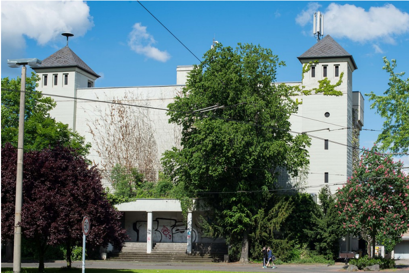
Hochbunker in Dottendorf, Quiriniusplatz (2013) Fotograf/Urheber: Caecilius Mauß
