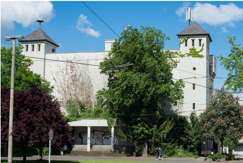
Hochbunker in Dottendorf, Quiriniusplatz (2013) Fotograf/Urheber: Caecilius Mauß
