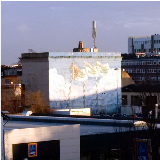
Der im Jahr 2015 abgerissene Hochbunker in der Bonner Weststadt / Karlstraße (2015) Fotograf/Urheber: Elmar Knieps
