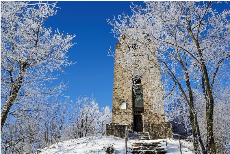
Winterlicher Blick auf den Kaiser-Wilhelm-Turm auf der Hohen Acht bei Adenau in der Eifel (2016). Fotograf/Urheber: Michael Schroeren
