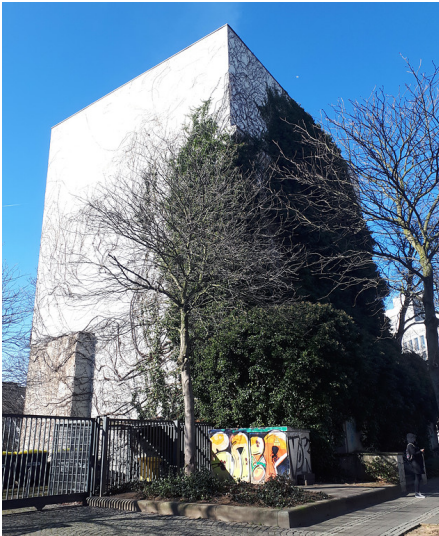
Der Hochbunker in Bonn-Zentrum (Windeckbunker) aus Richtung des Botplerplatzes gesehen (2018) Fotograf/Urheber: Florian Weber
