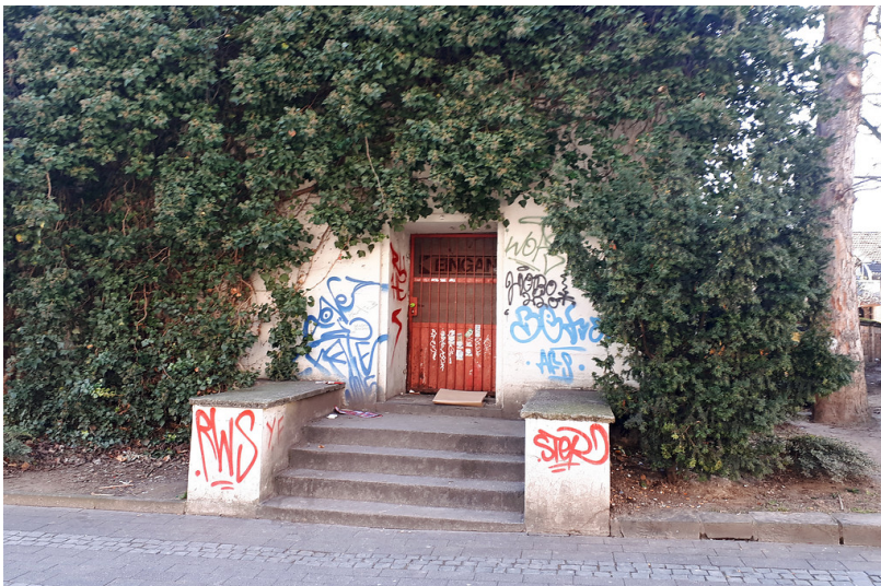
Die rechte der beiden Eingangstüren des Hochbunkers in Bonn-Zentrum (Windeckbunker), von der Budapester Straße aus gesehen (2018). Fotograf/Urheber: Florian Weber
