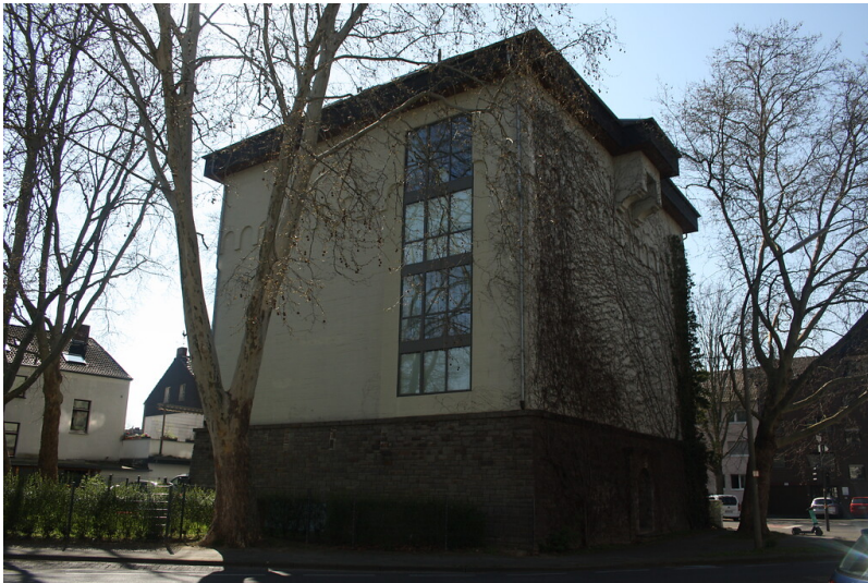
Hochbunker in der Goetheallee in Beuel (2020) Fotograf/Urheber: Sandro Golia
