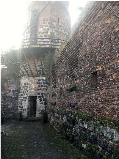
Mauern an der Mühle an der Südwestseite der Stadt Zons (2018) Fotograf/Urheber: Martin Sorg
