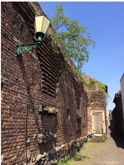
Innenseite der westlichen Außenmauer der Stadt Zons (2018) Fotograf/Urheber: Martin Sorg
