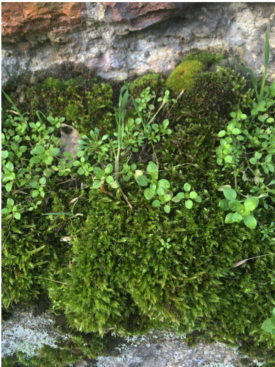
Innenseite der Westmauer der Stadt Zons (2018) Fotograf/Urheber: Martin Sorg
