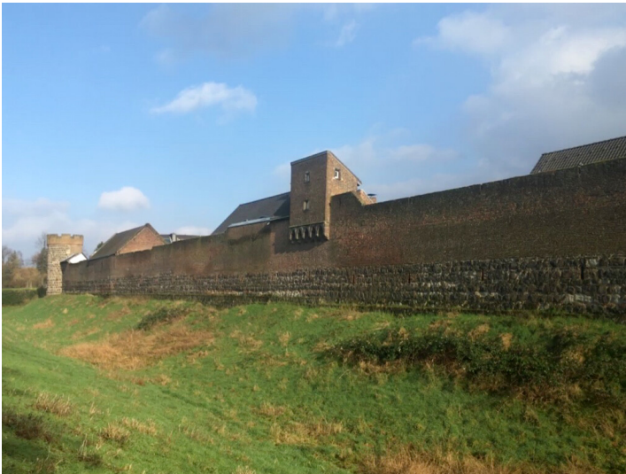
Aussenseite Westmauer Zons (2018) Fotograf/Urheber: Martin Sorg
