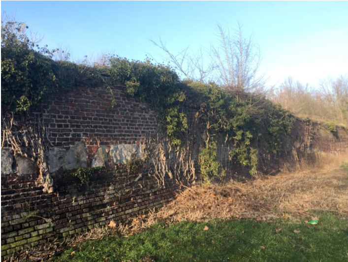
Mauer bei Haus Meer (2018) Fotograf/Urheber: Martin Sorg
