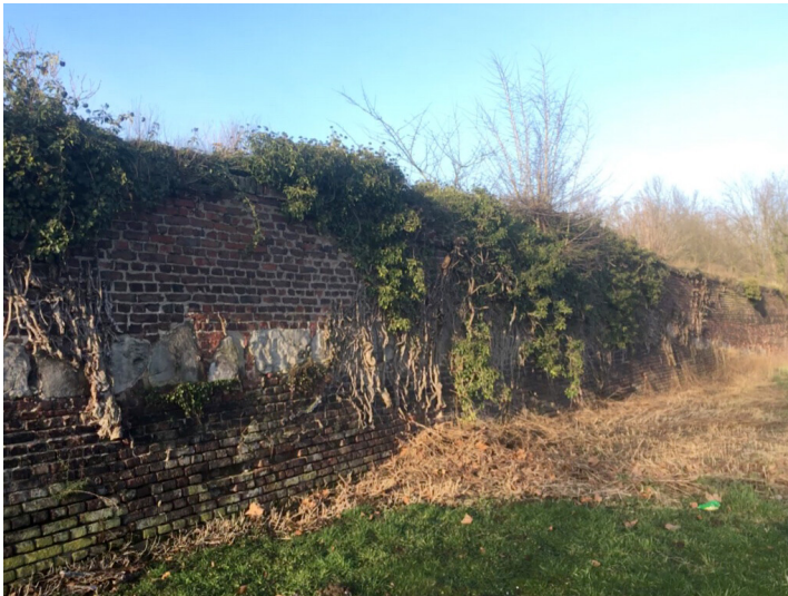
Mauer bei Haus Meer (2018) Fotograf/Urheber: Martin Sorg
