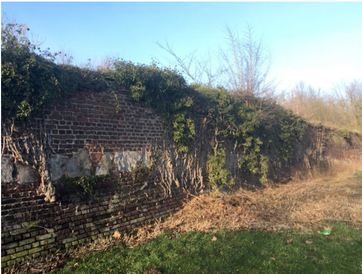
Mauer bei Haus Meer (2018) Fotograf/Urheber: Martin Sorg
