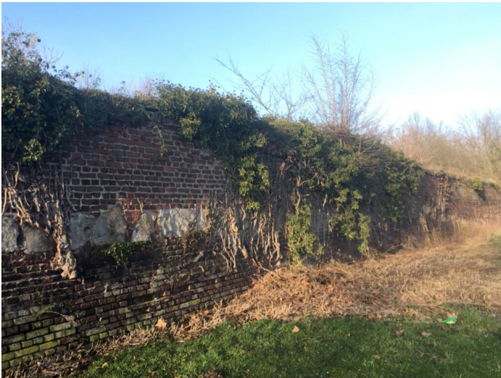
Mauer bei Haus Meer (2018) Fotograf/Urheber: Martin Sorg
