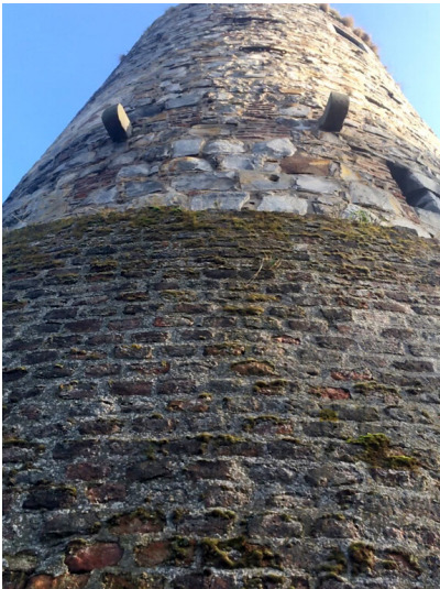
Mühlenturm in Liedberg (2018) Fotograf/Urheber: Martin Sorg
