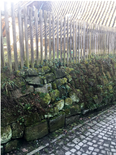
Mauer an der Mühlengasse in Liedberg (2018) Fotograf/Urheber: Martin Sorg
