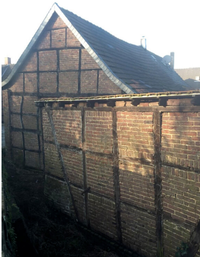
Fachwerkhaus vor der Brücke zu Schloss Liedberg (2018) Fotograf/Urheber: Martin Sorg
