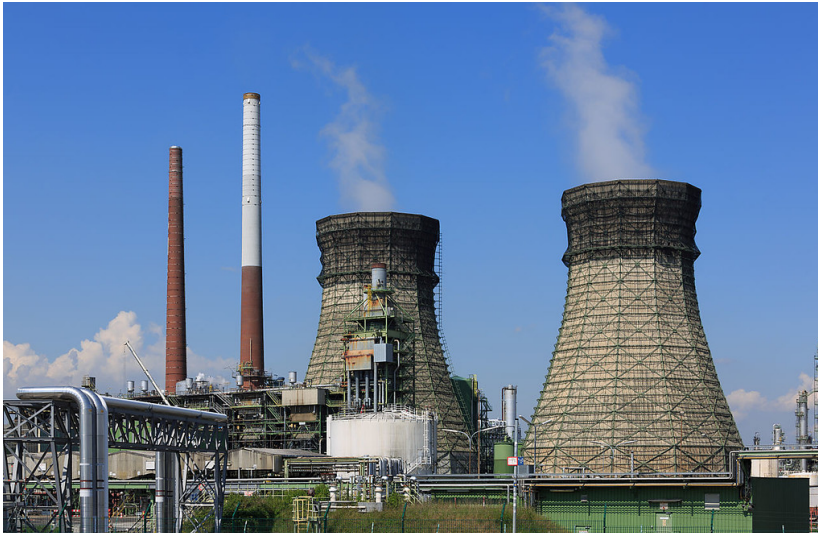
Industrieanlage der Rheinland Raffinerie mit Schornsteinen und Kühltürmen im Kölner Stadtteil Godorf (2014).
