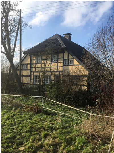
Fachwerkhaus bei Raderbroich (2018) Fotograf/Urheber: Martin Sorg
