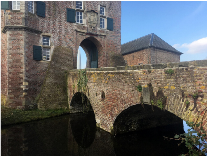
Mauern von Schloss Myllendonk (2018) Fotograf/Urheber: Martin Sorg
