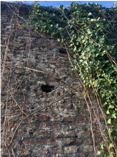
Stadtmauer Neuss (2018) Fotograf/Urheber: Martin Sorg
