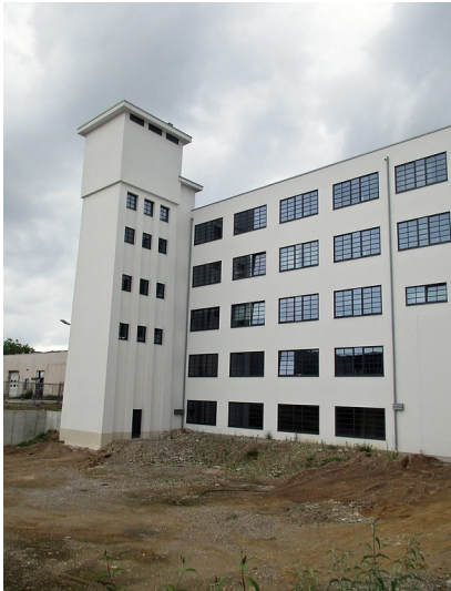
Der Wasserturm der Sidol-Werke in Braunsfeld ist heute Bestandteil eines Wohn- und Gewerbeckomplexes (2018). Fotograf/Urheber: Franz-Josef Knöchel
