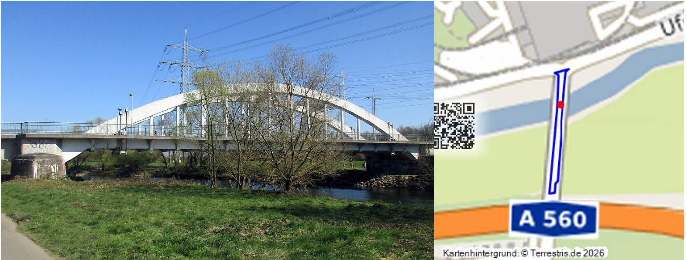
Die Melanbogenbrücke zwischen Troisdorf und Sankt-Augustin-Menden, aufgenommen von Westen (2020). Fotograf/Urheber: Franz-Josef Knöchel
