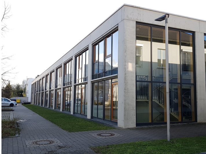
Sporthalle des Campus Koblenz der Universität Koblenz-Landau (2017) Fotograf/Urheber: Lena-Maria Tempelhagen
