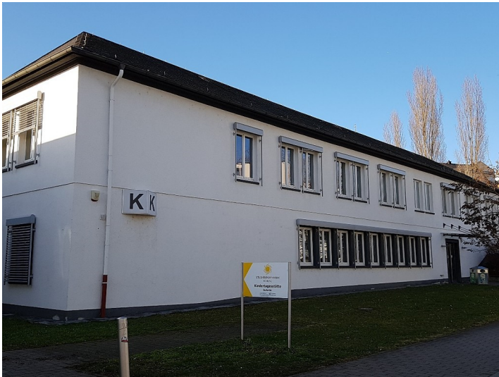
K-Gebäude des Campus Koblenz der Universität Koblenz-Landau (2017). Fotograf/Urheber: Lena-Maria Tempelhagen
