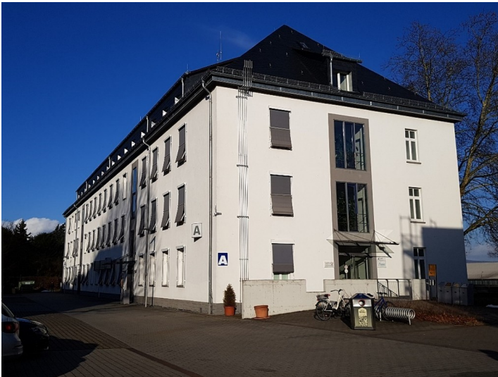
A-Gebäude des Campus Koblenz der Universität Koblenz-Landau (2017). Fotograf/Urheber: Lena-Maria Tempelhagen
