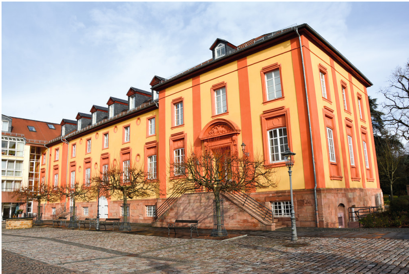
Südwestansicht des wiederaufgebauten Ostflüges des Barockschlosses in Kirchheimbolanden. Das Dach ist mit kleinen, schieferverkleideten Giebeln versehen (2015). Fotograf/Urheber: Hans-Günther Clev
