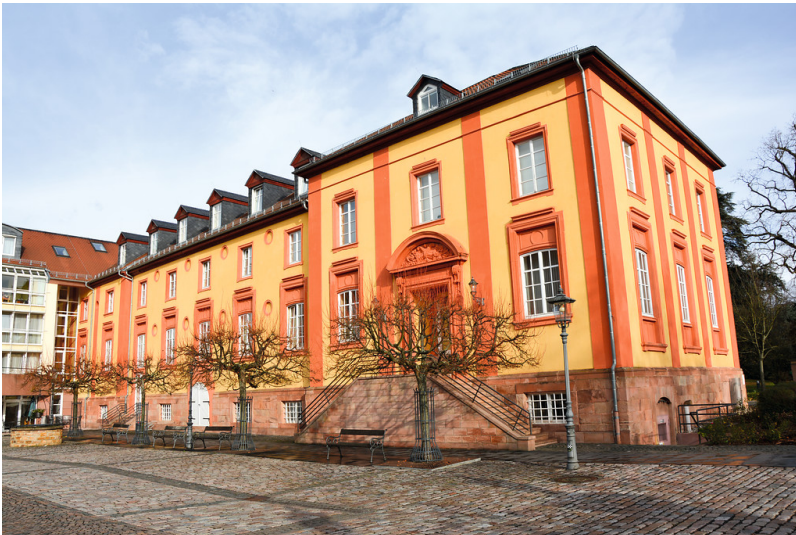
Südwestansicht des wiederaufgebauten Ostflüges des Barockschlosses in Kirchheimbolanden. Das Dach ist mit kleinen, schieferverkleideten Giebfenstern versehen (2015). Fotograf/Urheber: Hans-Günther Clev
