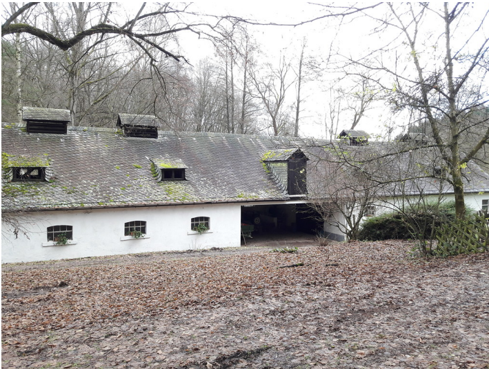
Wirtschaftsgebäude der Nonnenmühle bei Geisenheim (2017) Fotograf/Urheber: Bob Fritz
